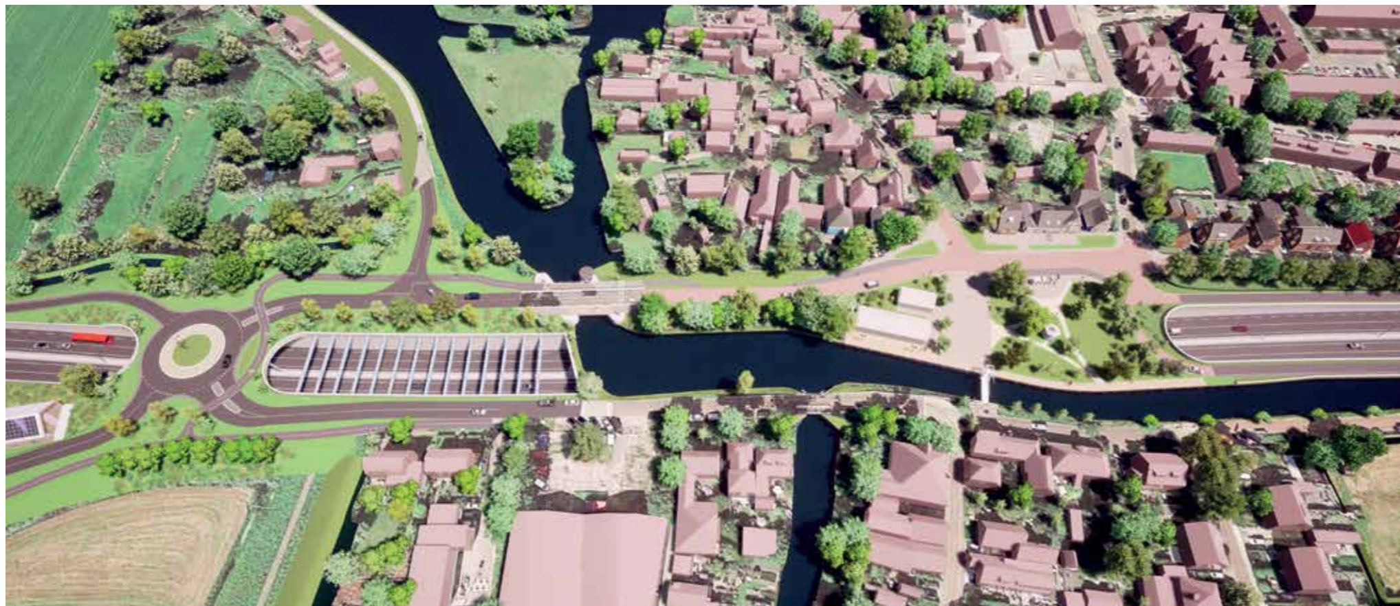
Totaaloverzicht vanuit de lucht © Arcadis Architecten (Tom Kramer), in opdracht van Provincie Noord-Holland
